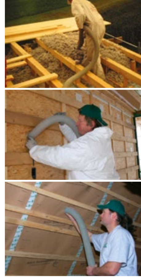
Isolamento di copertura con getto di fiocchi di cellulosa in estradosso, Casa Willeit a Gais, arch. A. Willeit. (Foto Fotostudio Eheim, Bressanone)
