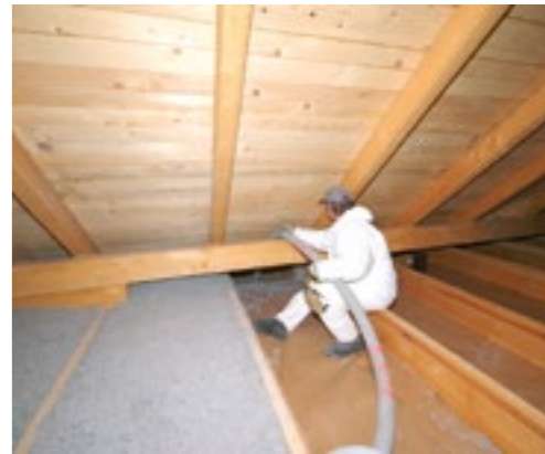
Isolamento di sottotetto non praticabile con insufflaggio di fiocchi di cellulosa. (Documentazione Leo Bodner © Edilizia Ecologica)
