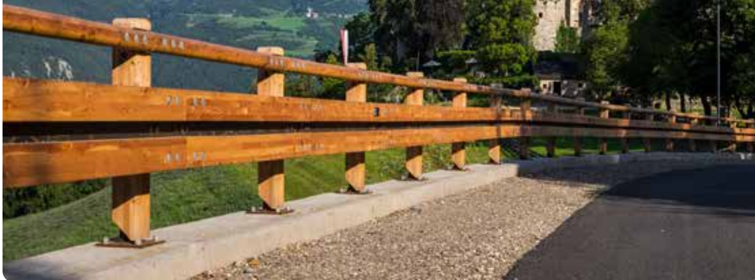
Barriera H2 bordo ponte in legno lamellare di larice certificato prodotto in Alto Adige. Castello di Presule, provincia di Bolzano
